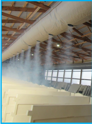
Besonders bei Einzelboxen müssen Größe und Anordnung der Luftdüsen von einem Experten genau berechnet werden.
