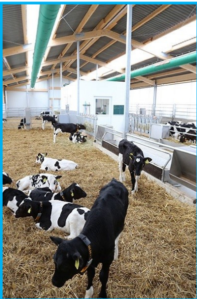
Eine gute Luftspülung der Gruppenboxen vermeidet Zugluft und Stellen mit höheren Schadgasgehalten in der Luft.
