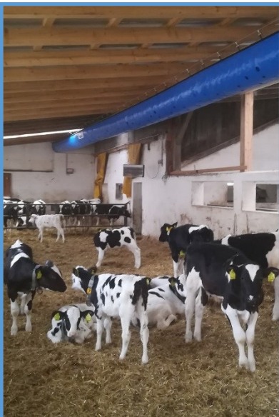
In vielen älteren Kälberställen entspricht die Luftqualität nicht den Erfordernissen. Gut geplante Schlauchlüftungen verbessern das Stallklima deutlich.
