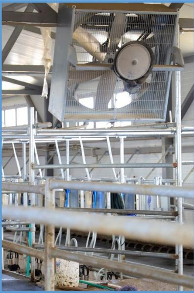
Lüfter mit Wasserdüse eignen sich für gut belüftete Gebäude. Ist eine Durchlüftung nicht gegeben, entsteht feucht-warme Luft, die die Wärmeabgabe der Tiere behindert. Foto: KFM
